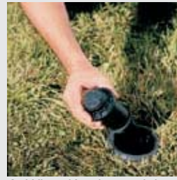
2. Wkręcić w jego miejsce mechanizm PGP-ATR.
