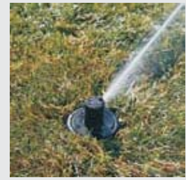
3. Ustawić zakres pracy oraz kierunek nawadniania.
